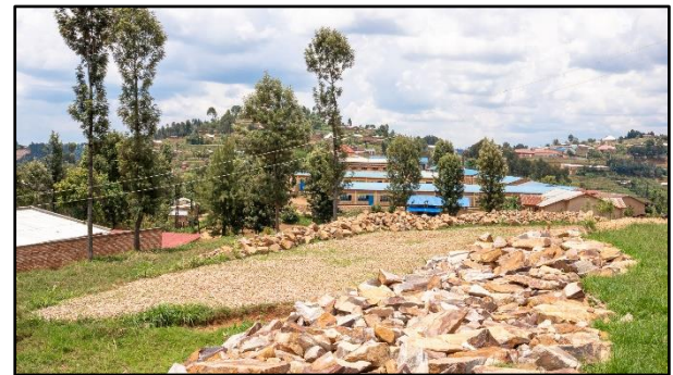
De parking voor het kerkgebouw. Op de achtergrond het schoolcomplex van Murama waar momenteel Blok 1 van de nieuwe kleuterklassen wordt gebouwd
