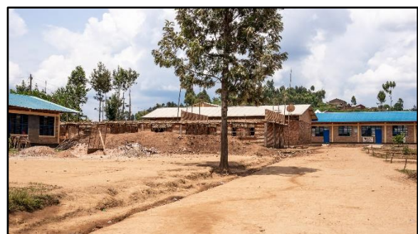
In september werden de werkzaamheden voor de bouw van de kleuterklassen in GS Murama aangevat.
