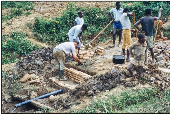
Anno 1984: door de bron in Muyanza aan te boren en te capteren voorzag broeder Cyriel de inwoners van een watervoorziening, wat essentieel was voor hun gezondheid en dagelijkse levensonderhoud.
